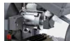
Separate boiler fan unit
